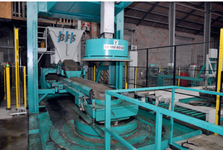
Ortsfestes Betonsilo mit zusätzlichem Förderband
