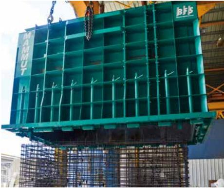
Die vorbereiteten Bewehrungskörbe auf den Untermuffen werden per Kran mit dem Formmantel abgeholt und über den Formkern in der Anlage gestellt.
