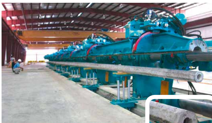
Процесс распалубки формы для центрифугирования Spun Pole Demoulding Process
