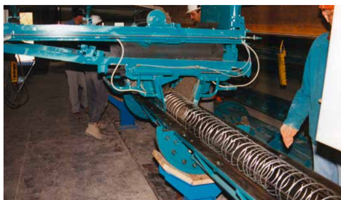
Процесс заполнения формы бетоном
