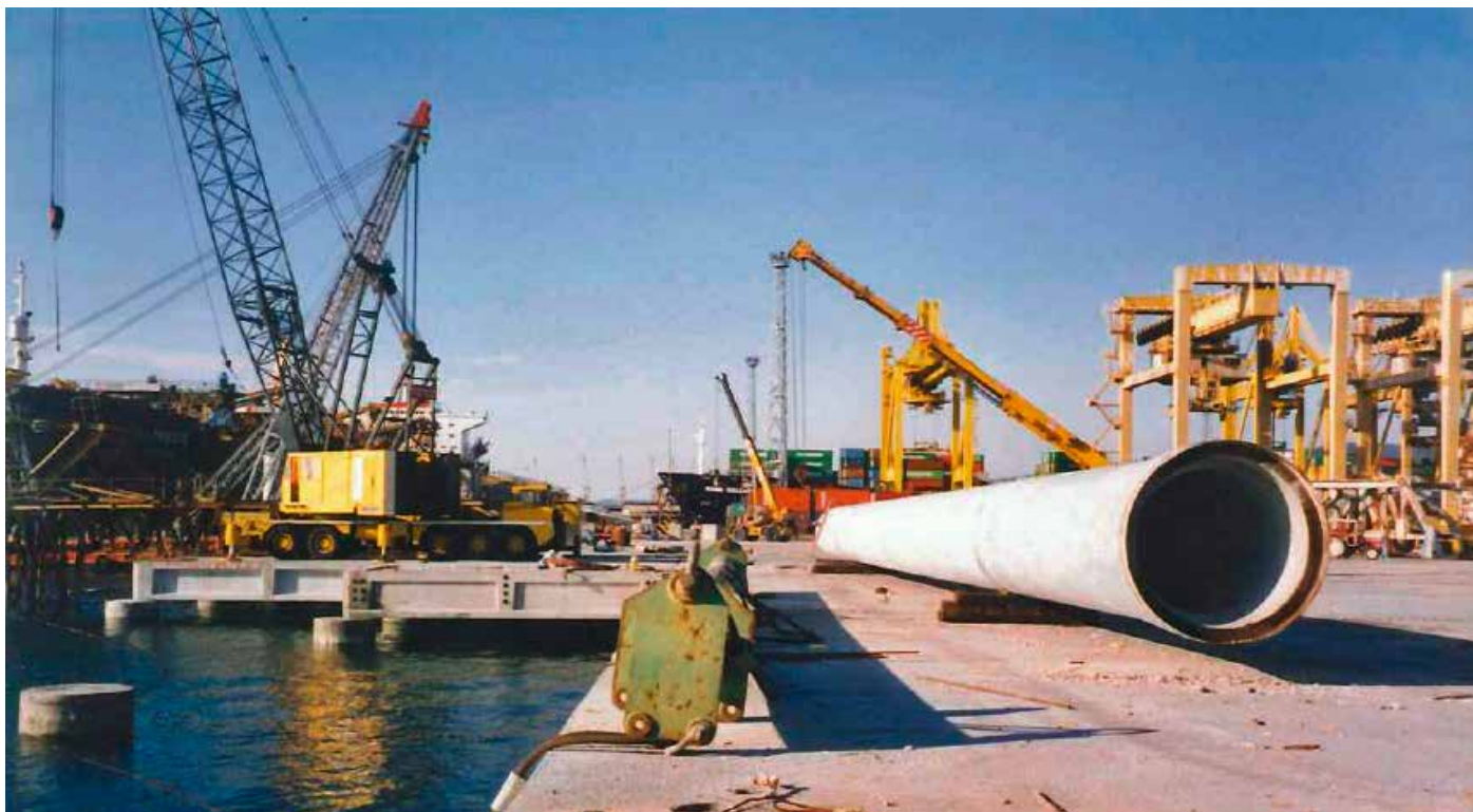
Свая для монтажа платформы в порту
