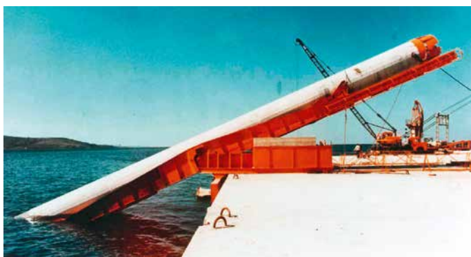
Наклонная станция для установки свай
